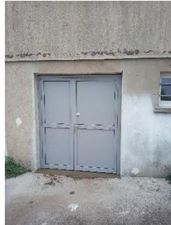
Die Instandsetzungsarbeiten am ehemaligen Fußballumkleideraum werden fortgesetzt und der untere Raum wird vollständig für die Gemeindegewerkstatt bestimmt. Die maroden Fenster wurden ebenso wie die Türen ausgetauscht, die Elektroinstallation ist abgeschlossen. Die Malerarbeiten wurden durchgeführt.
