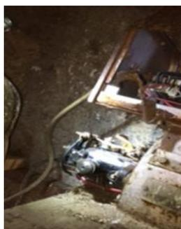
la vétusté de l'installation électrique a été relevée. Sa mise en conformité a été votée pour 3046.40 Euros HT. Le remplacement de la motorisation des cloches 2 & 3 a été décidée pour 3285 Euros HT.
